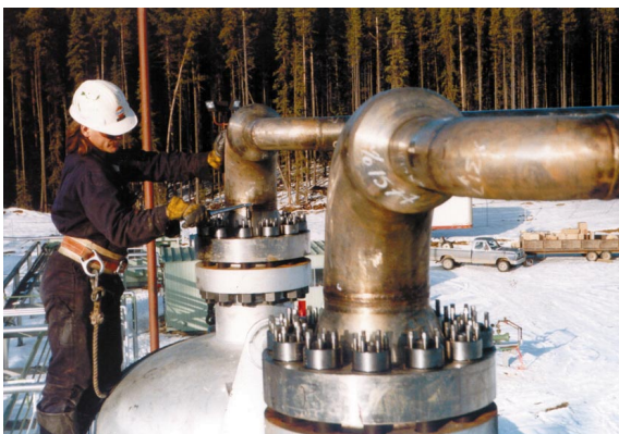
脱水タワーのフランジの締結に。
