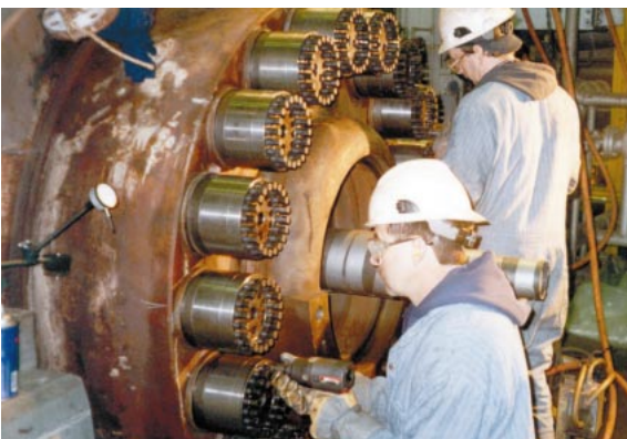
ボイラ給水ポンプのカバーの締結に。
